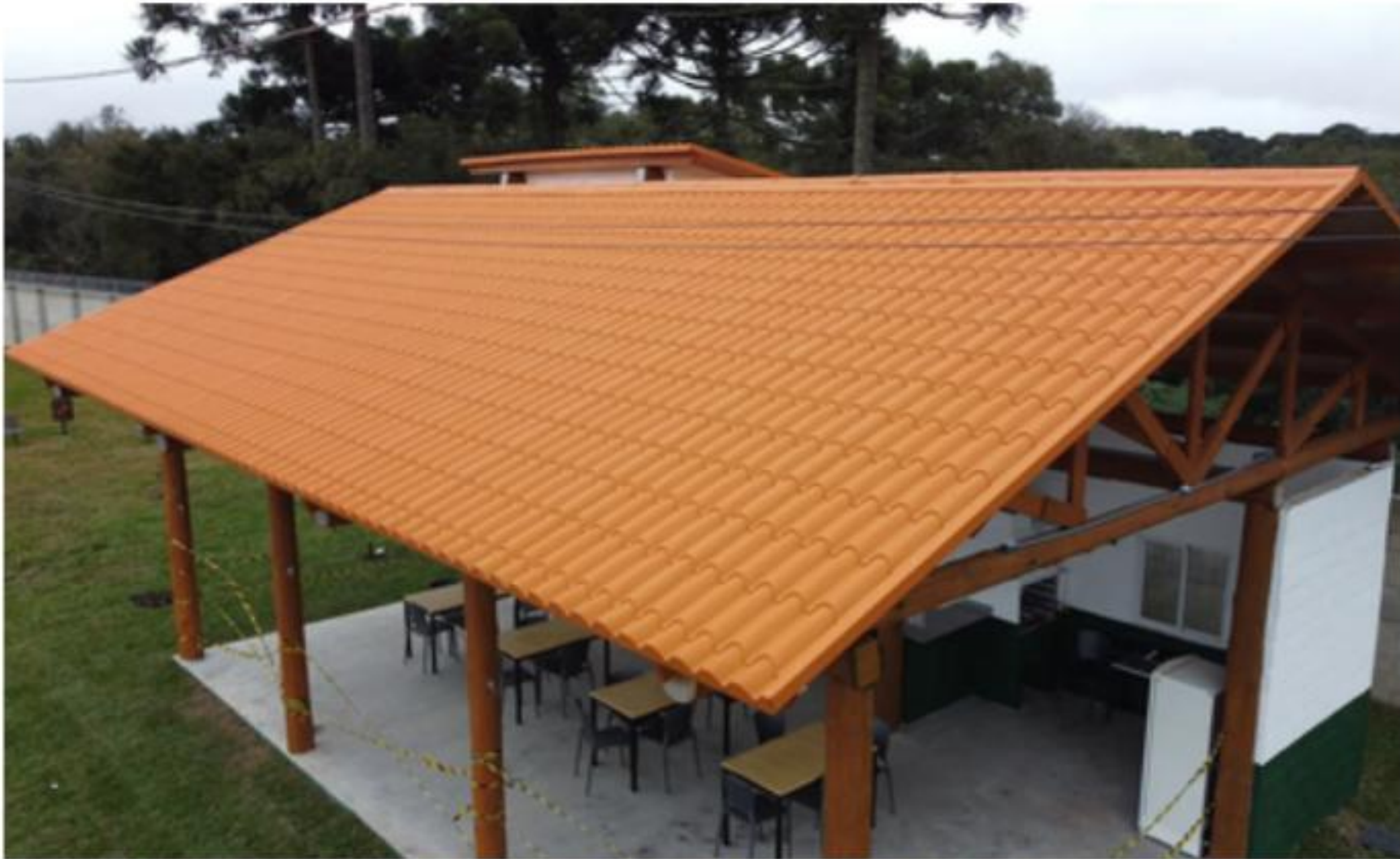
Obra: Residencial - Telha Colonial - Curitiba/PR
