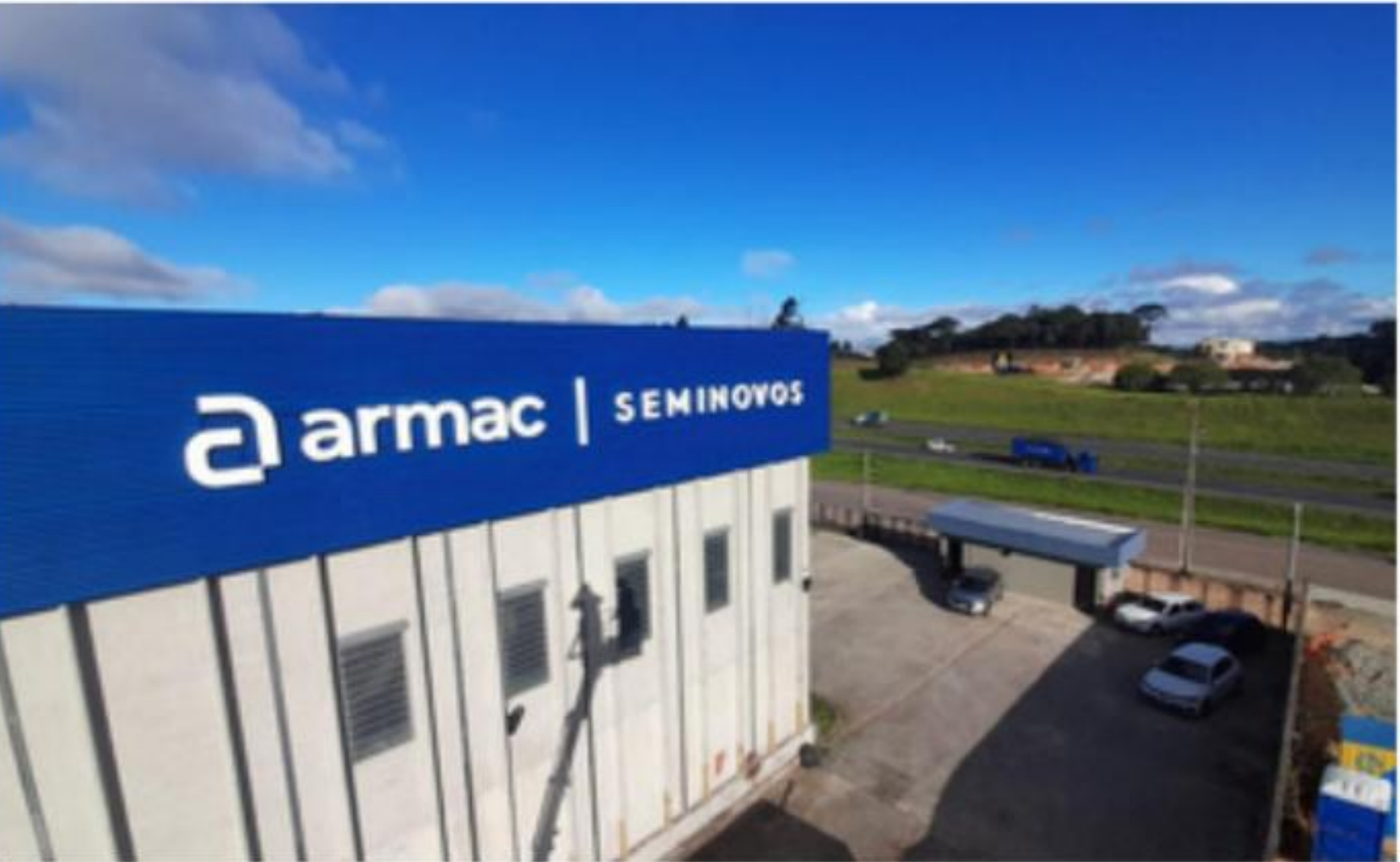
Obra: Armac - São José dos Pinhais/PR
