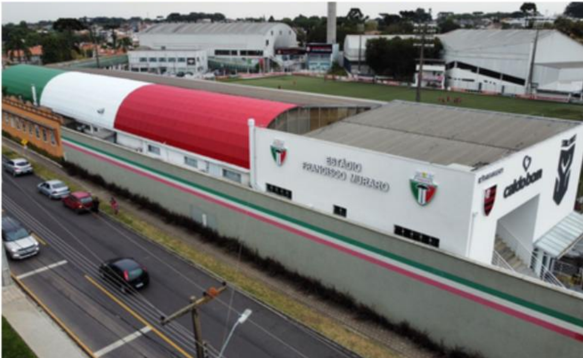
Obra: Estádio Francisco Muraro - Trieste - Santa Felicidade/PR
