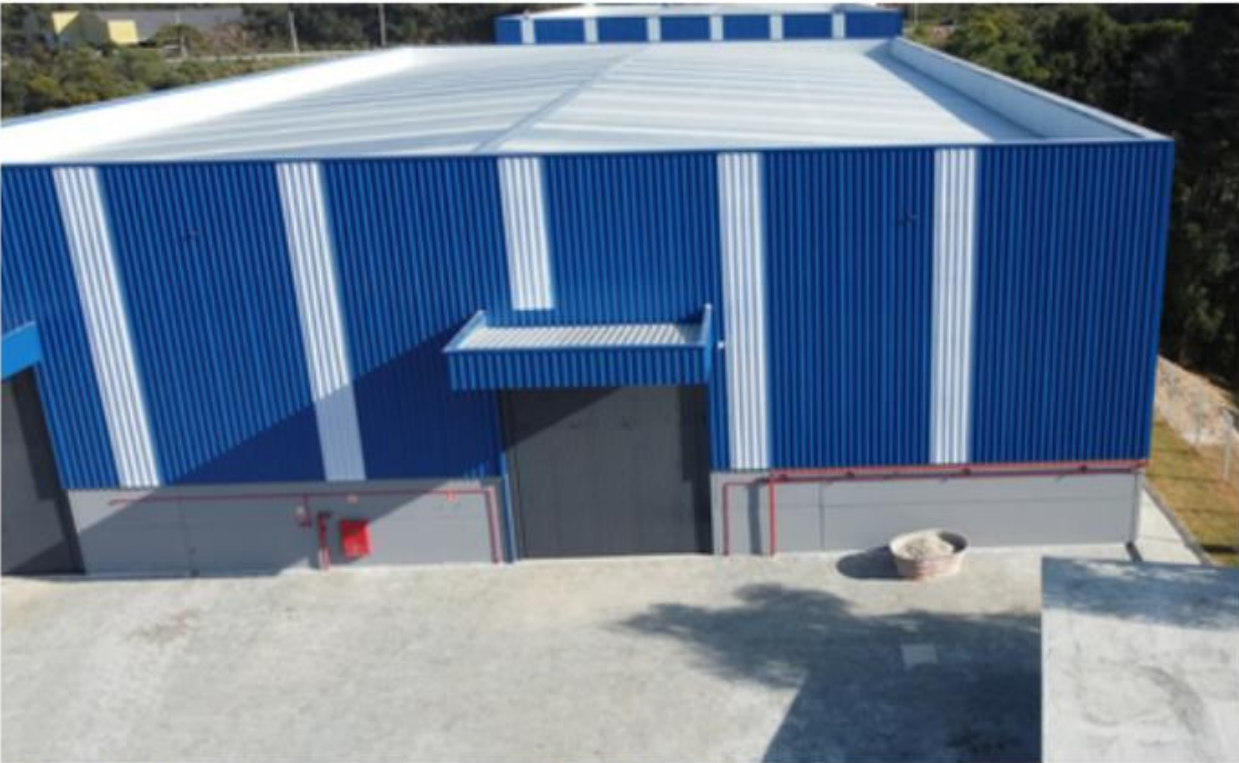
Obra: Fibrarte - Lux telhas - Curitiba/PR
